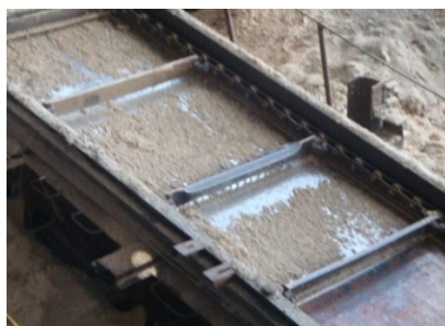
Figura 1. Combinación de madera, tubos laminados, viga canal
