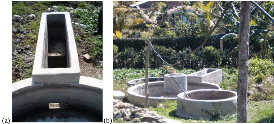
Figura 4. (a) Cabina de acceso al digester y comunicación con el tanque de compensación. (b) Conexión de la tubería flexible, tanque de mezcla, digester y tanque de descarga al fondo.
