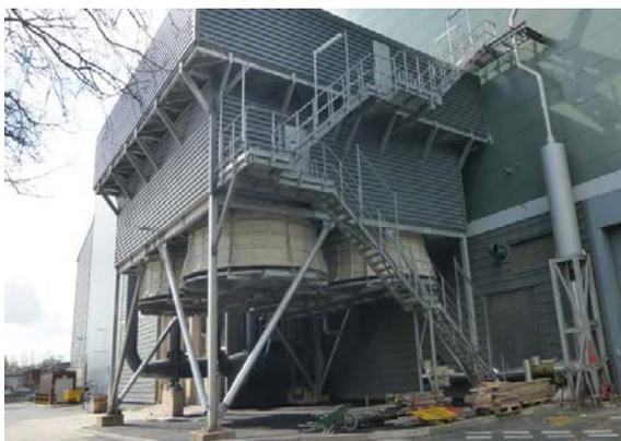
**Figura 4.** Condensador seco compacto (4 unidades de 12 MW cada una) instalado en el central azucarero. Crystalsev1, Brasil
