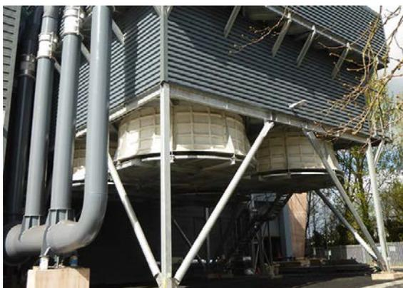
**Figura 3.** Condensador seco compacto (cuatro unidades de 10 MW cada una), instalado en una planta térmica de una fábrica de azúcar de remolacha en Marsella, Francia
