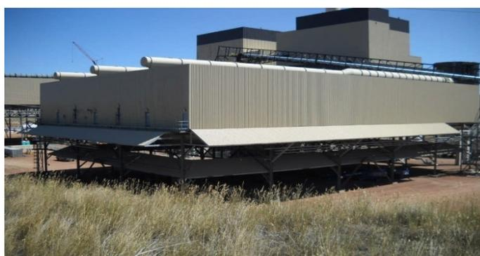
**Figura 5.** Condensador seco compacto (3 unidades de 8 MW cada una). En proceso de montaje (Ingenio Crystalsev2. Brasil)
