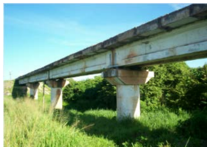
Figura 3. Puente km 560 del Ferrocarril Central
